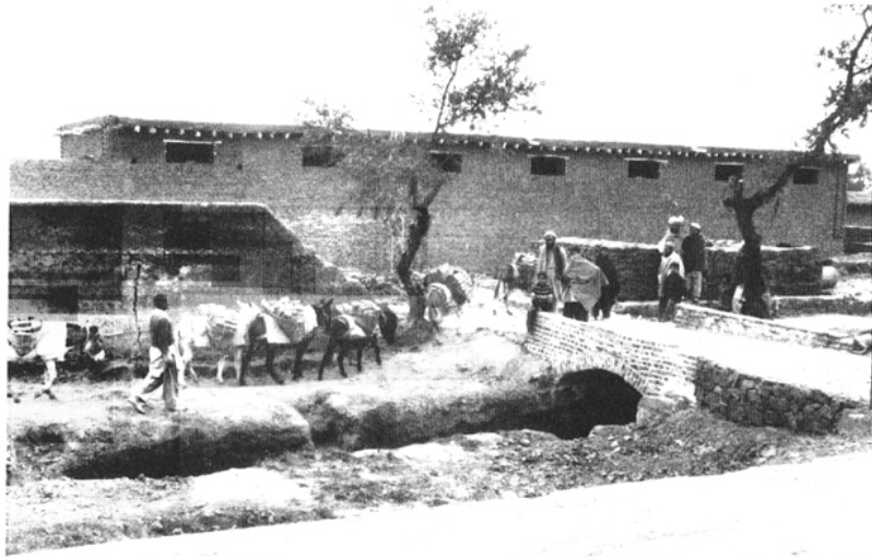
ARC-Ambulanzgebäude im Lager Baghicha, Pakistan, 1984
