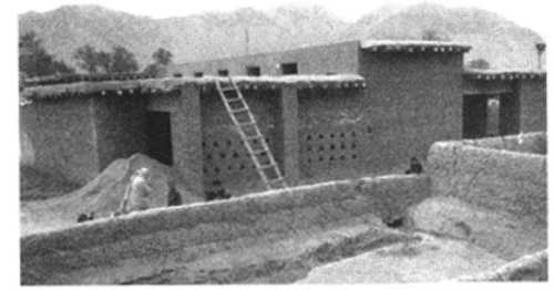
Ambulanzgebäude in Baghicha, 1984
