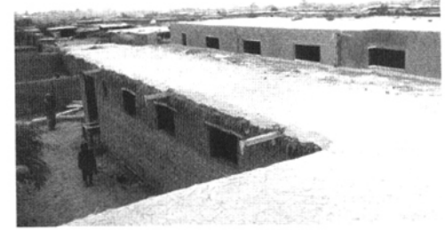
Ambulanzgebäude in Baghicha, 1984
